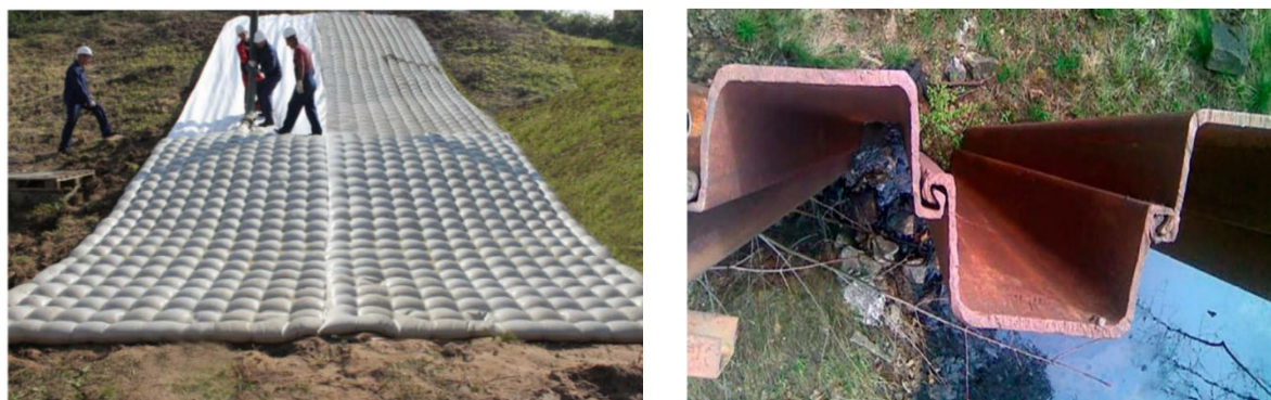
Рис. 3 а) Укрепление берегов, б) металлический шпунт
