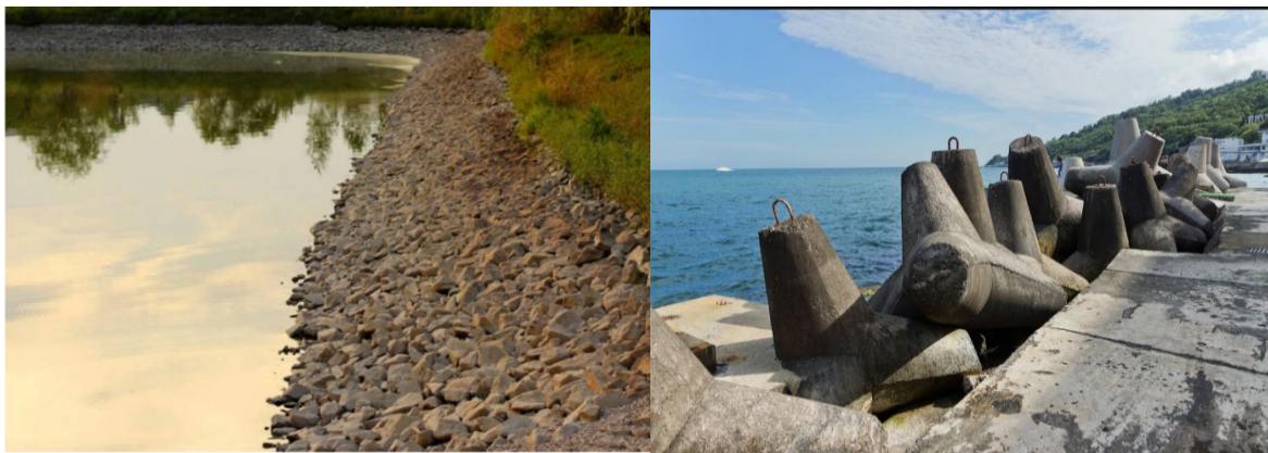
Рис. 2 а) Укрепление берегов каменная наброска, б) железобетонный тетрапод
