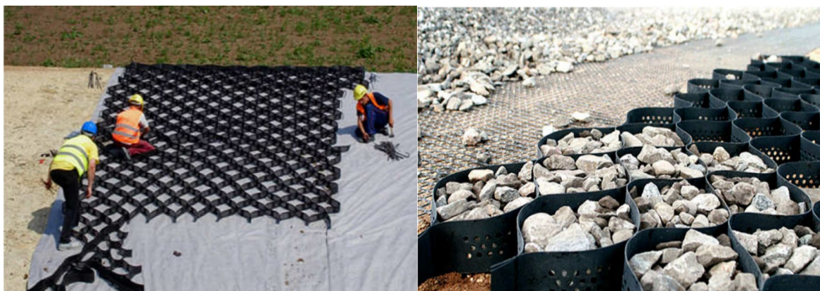
Рис. 4 а) Укладка георешетки на откосе, б) заполнение георешетки щебнем.
